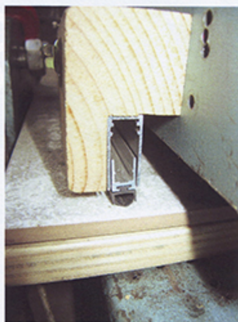
Particolare della sezione lato serratura.
